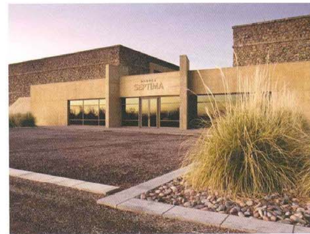
La construcción de Séptima replica la técnica milenaria que utilizaban los pueblos originarios: la pirca, un método que consiste en cortar y apilar piedras naturales
